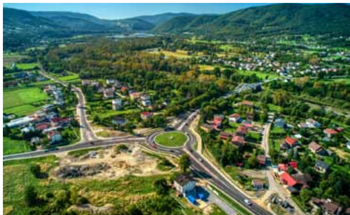
... i po przebudowie
