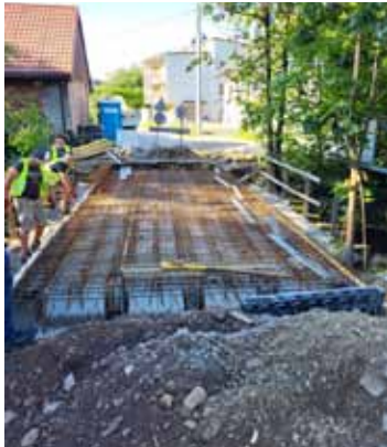
Remont mostu ul. Krucza w Czańcu
