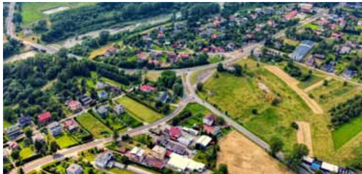
Skrzyżowanie przed przebudową...
