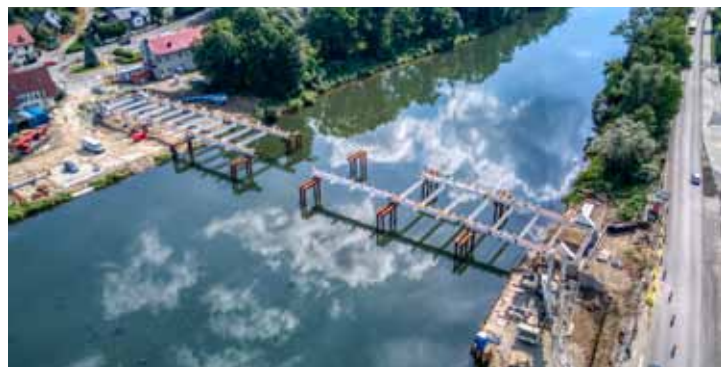
Nowy most w budowie
